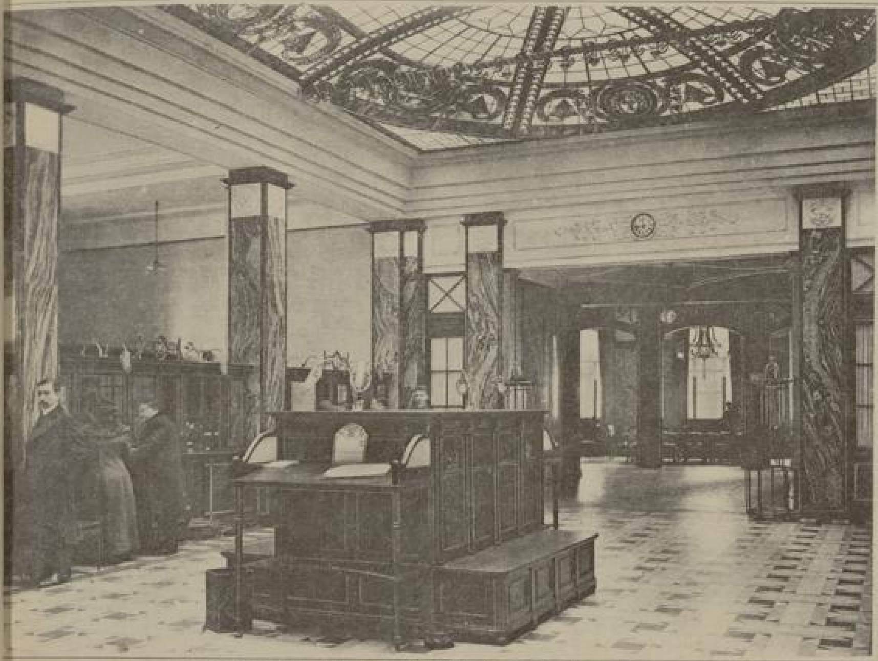
Dresdner Bank. Blick aus der Kassenhalle nach dem Eiseisaa.
