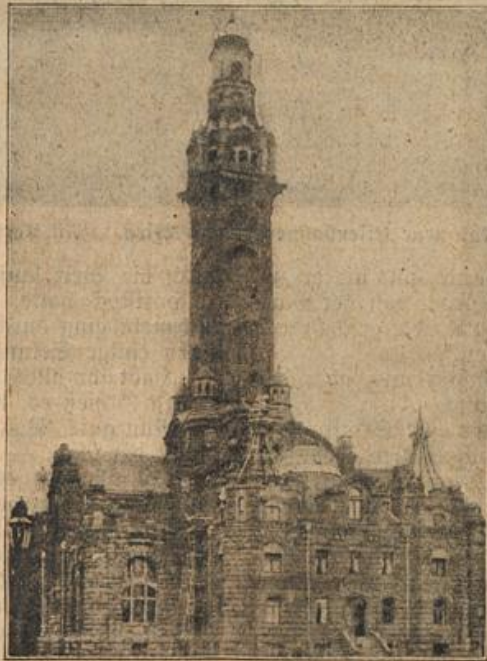
Das staatliche Fernheizwerk in Dresden.
