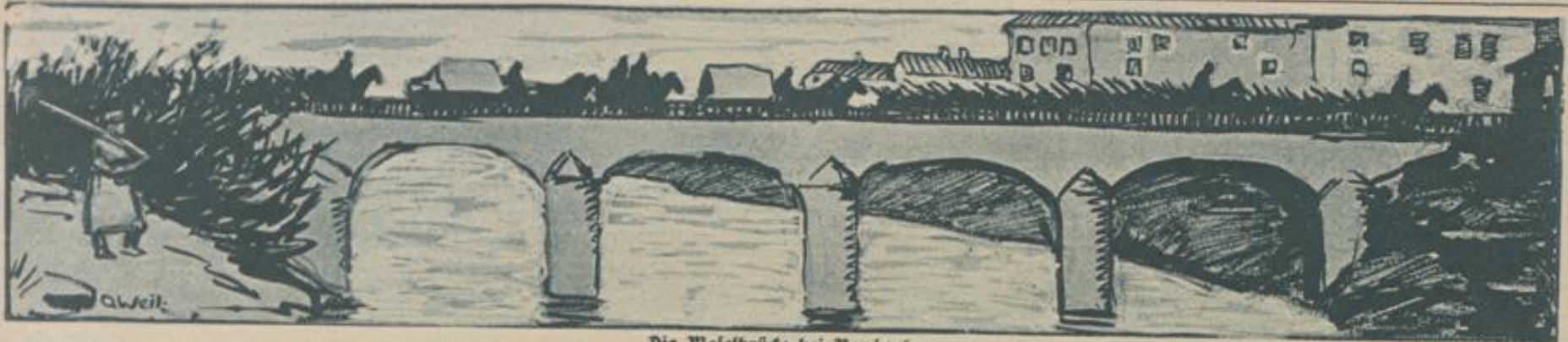
Die Moselbrücke bei Novéant.
