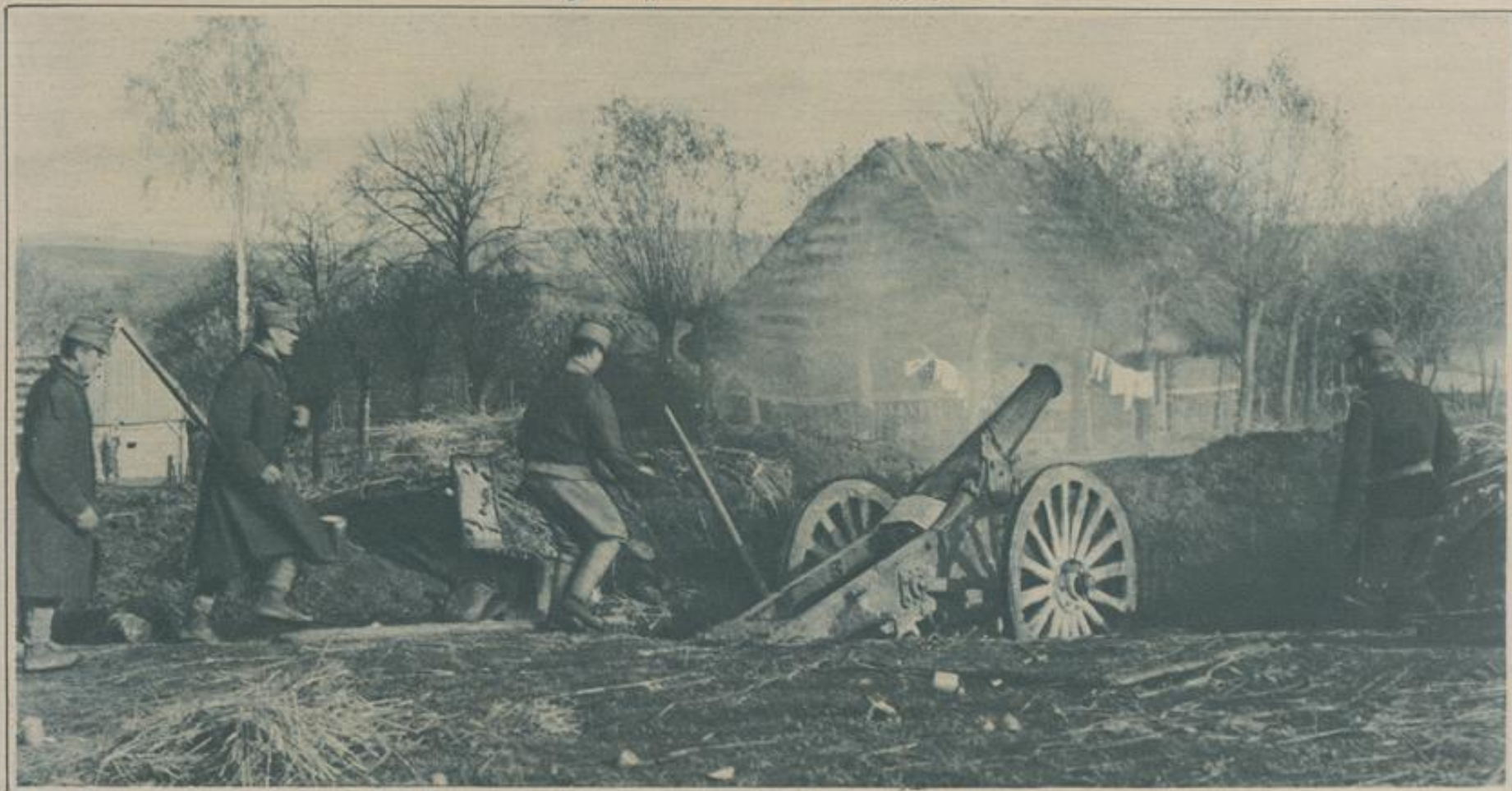
Feuernde schwere österreichische Haubitzenbatterie.
