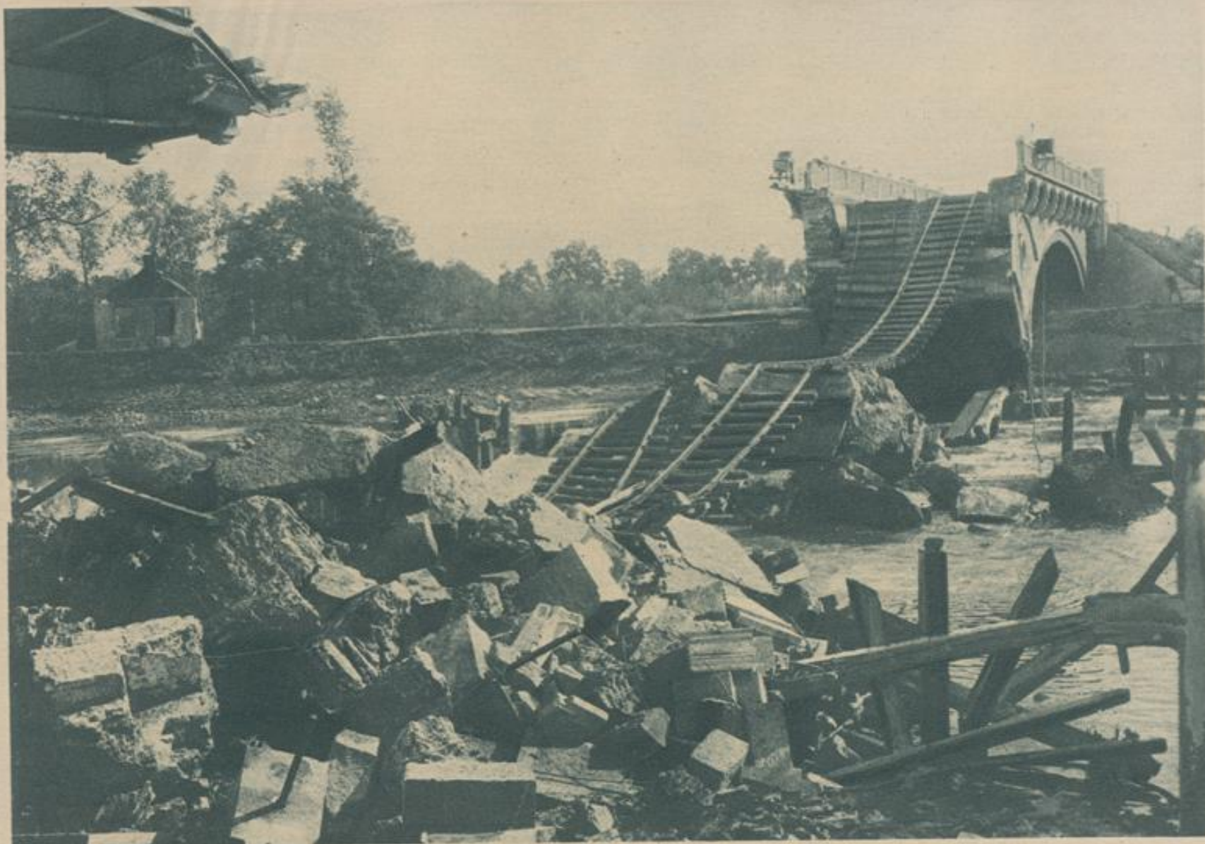
Die von den Belgiern zerstörte Brücke von Duffel. Die Brücke wurde zerstört, um unser Vordringen nach der Küste aufzuhalten.
