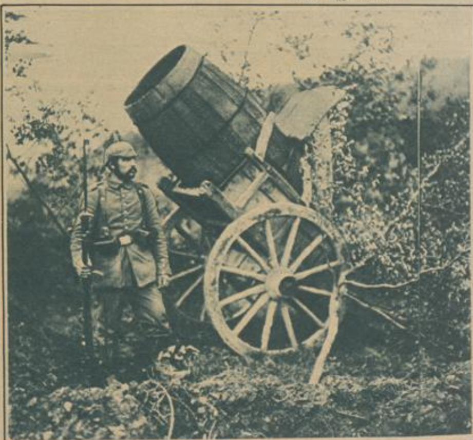
Wie man die feindlichen Flieger täuscht — schwere Haubitzen aus Tonnen und alten Handwagen.
