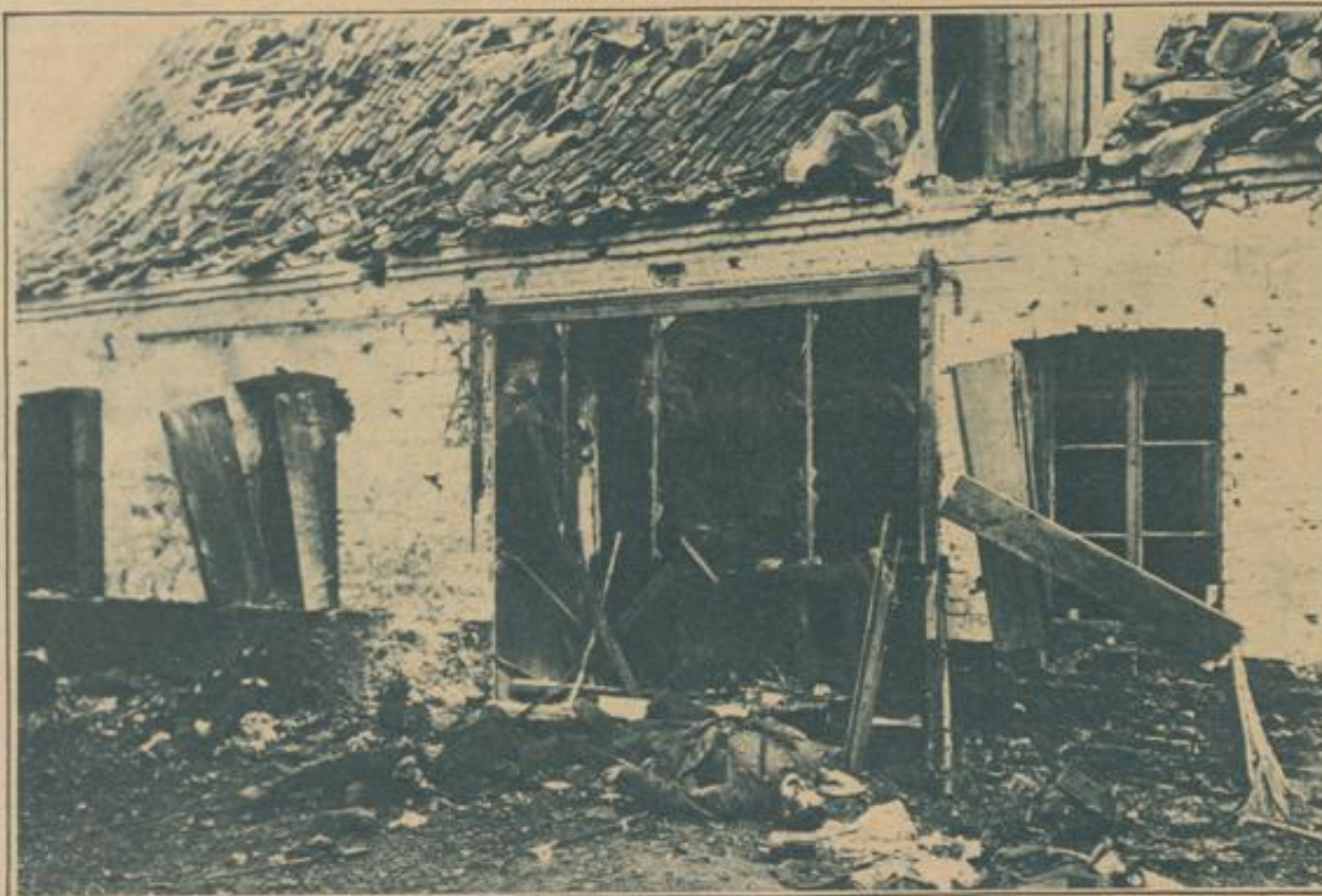
Ein Haus in Laurent, das vor der Erstürmung von einer Granate getroffen wurde.
