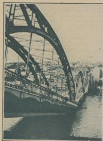
Schlecht gesprengte Maasbrücke.
