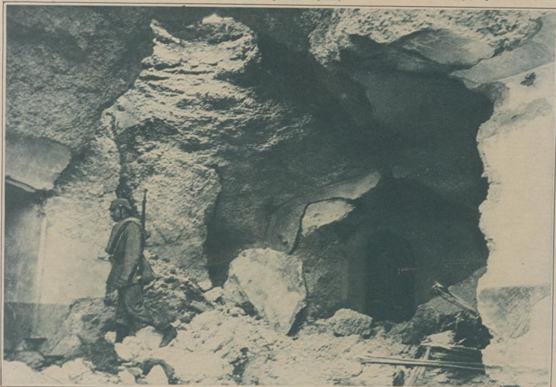
Das Loch, das ein 42 cm-Geschoss im Fort Wavre gerissen hat. Phot. Voedeker.
