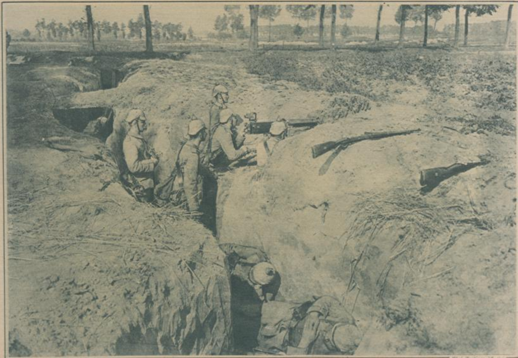
Eiliges Ausheben von Schützengräben an der Maas.
