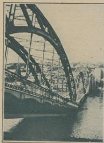
Schlecht gesprengte Maasbrücke.
