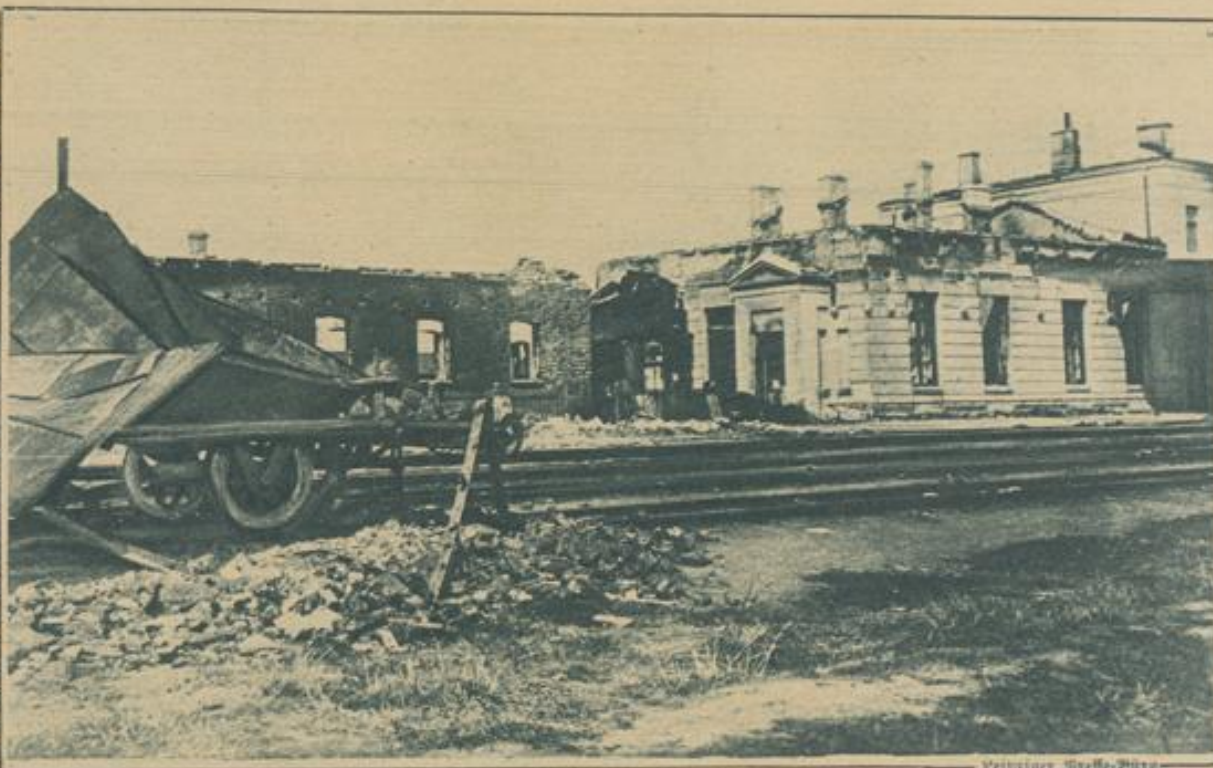
Eine zerstörte Eisenbahnstation.
