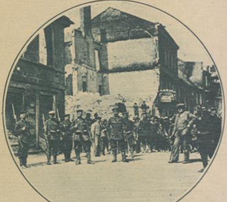
Deutsche Soldaten bewachen die Aufräumarbeiten an zusammen- geschossenen Häusern in der Dresdenerstraße in Kalisch.
