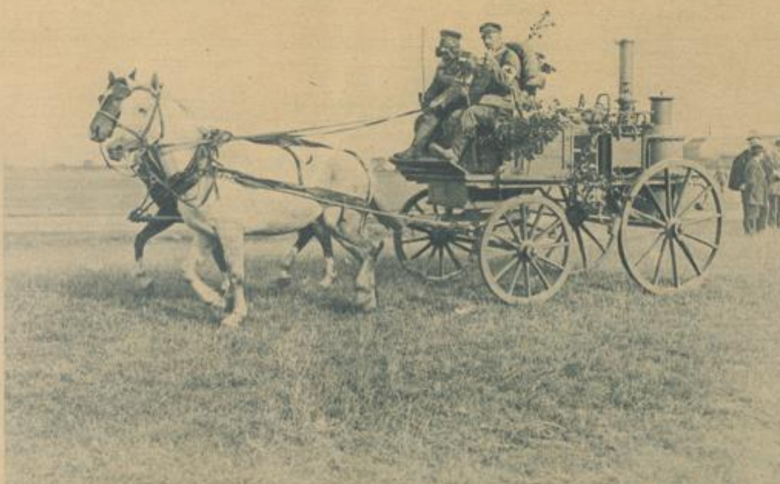
Von der Sanitätskolonne: Ein Wagen mit einem Apparat zum Destillieren von Wasser.
