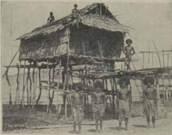
Ein Pfahlbau der Papuaner in Kaiser-Wilhelms-Land auf Neuguinea. Die an der Küste wohnenden Papuaner errichten ihre Häuser zum Schutz gegen Ueberschwemmungen und Ungeziefere auf 1-3 m hohen Pfählen. Als Treppe dient gewöhnlich ein schräg angelegter Pfahl. Die Wohnungen liegen zu Dörfern von 10-150 Häusern zuammen.
