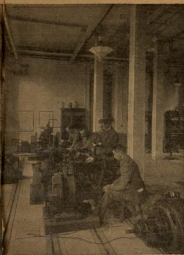
Elektrotechnische Lehranstalt, Arbeitsgruppe im Maschinenraum.
