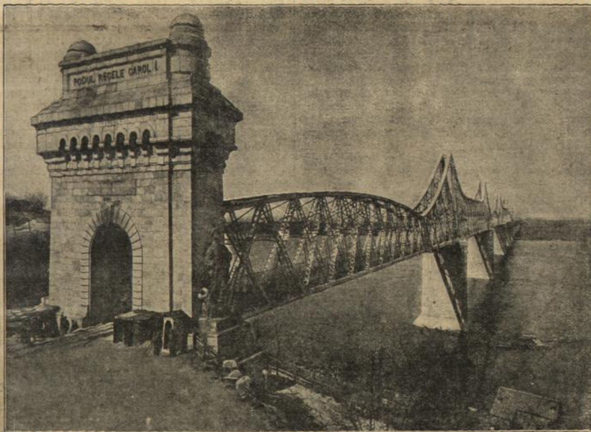
Riesen-Brückenbau deutsch-bulgarischer Pioniere.
