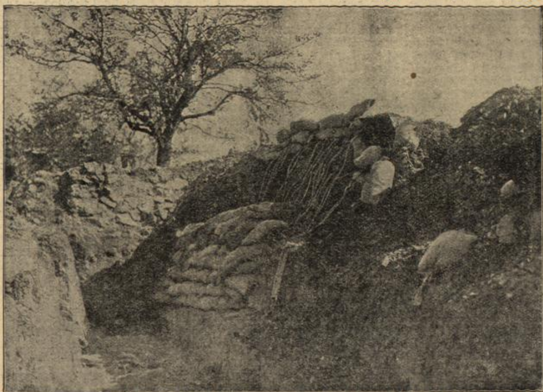
Russischer Graben mit eingebaute Gasstation. Phot. Conrad Hünic, Berlin.
