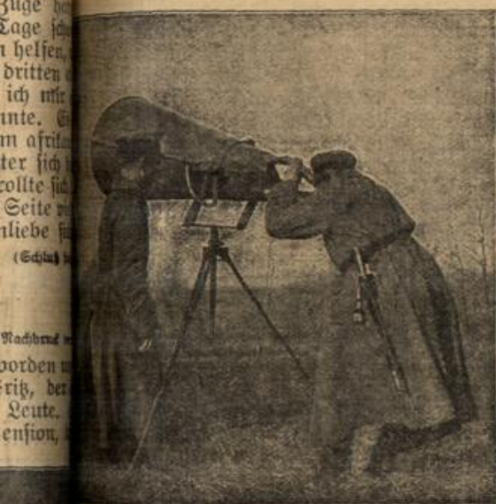
Apparat, mit dem die Annäherungsrichtung feindlicher Flugzeuge festgestellt wird.
