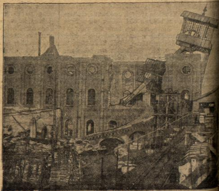
Eine vollständig zerstörte Kohlengrube bei Vene.
