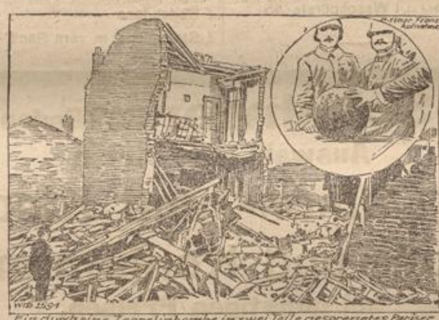
Ein durch eine Zeppelin bombe in zwei Teile gesprengtes Pariser Wohnhaus. Oben rechts eine nicht kreierte Bombe
