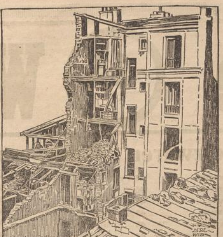
Ein durch eine Zeppelin bombe zerstörtes Pariser Vorstadthaus.
