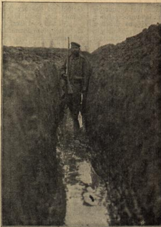
Verbindungsgraben zum Befördern von Munition und Nahrungsmitteln nach den vordersten Schützengräben.
