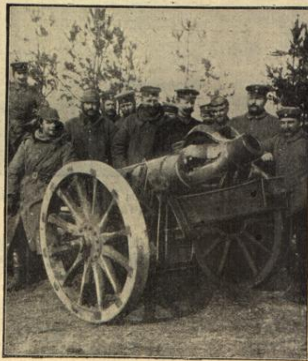
Ein russisches Geschütz, das von einer im Lauf trepten Granate aufgerissen wurde.
