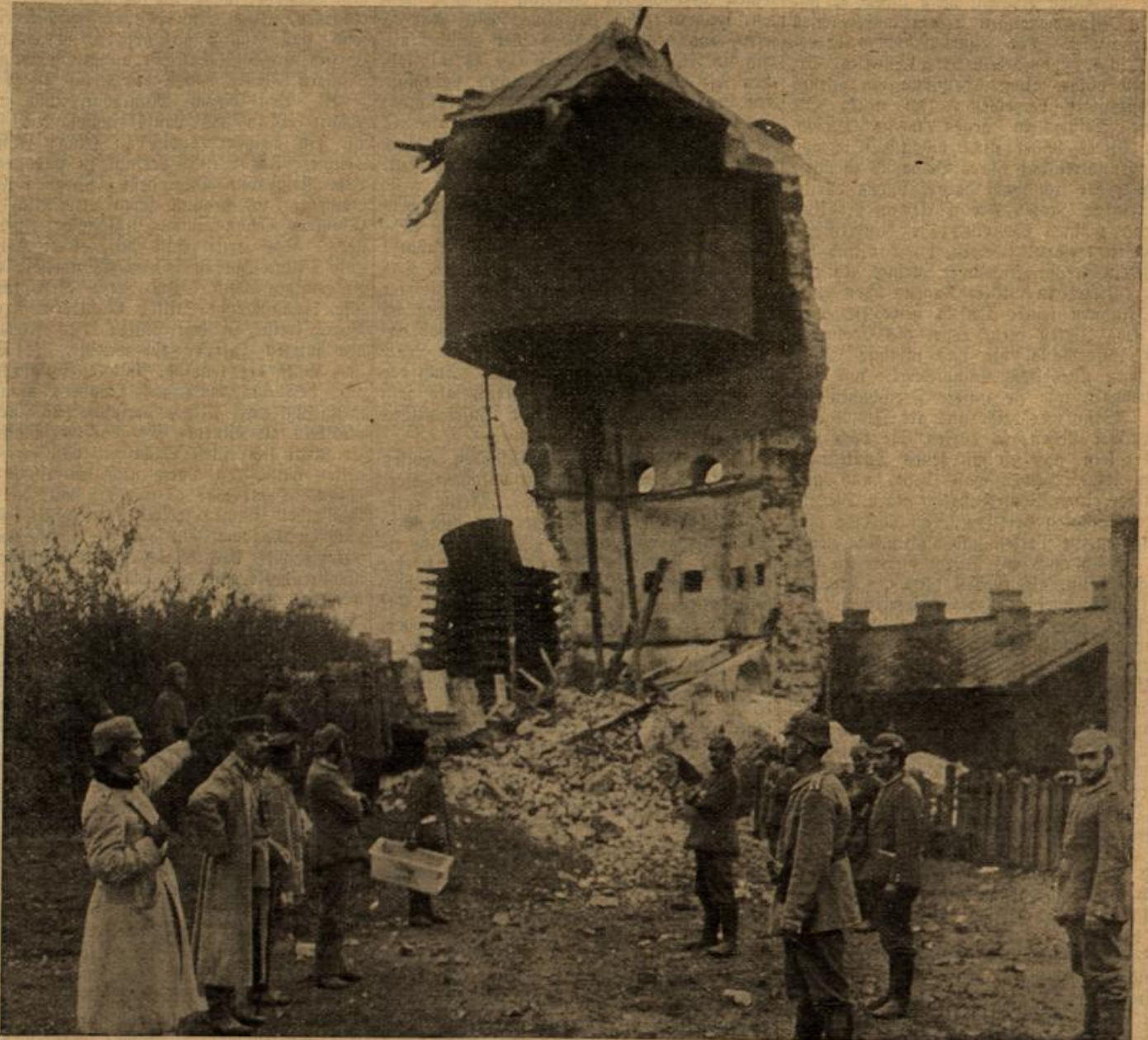
Ein von deutschen Truppen zerstörter Wasserturm bei Lodz, von dem aus Zivilpersonen den Feinden Lichtsignale gaben.
