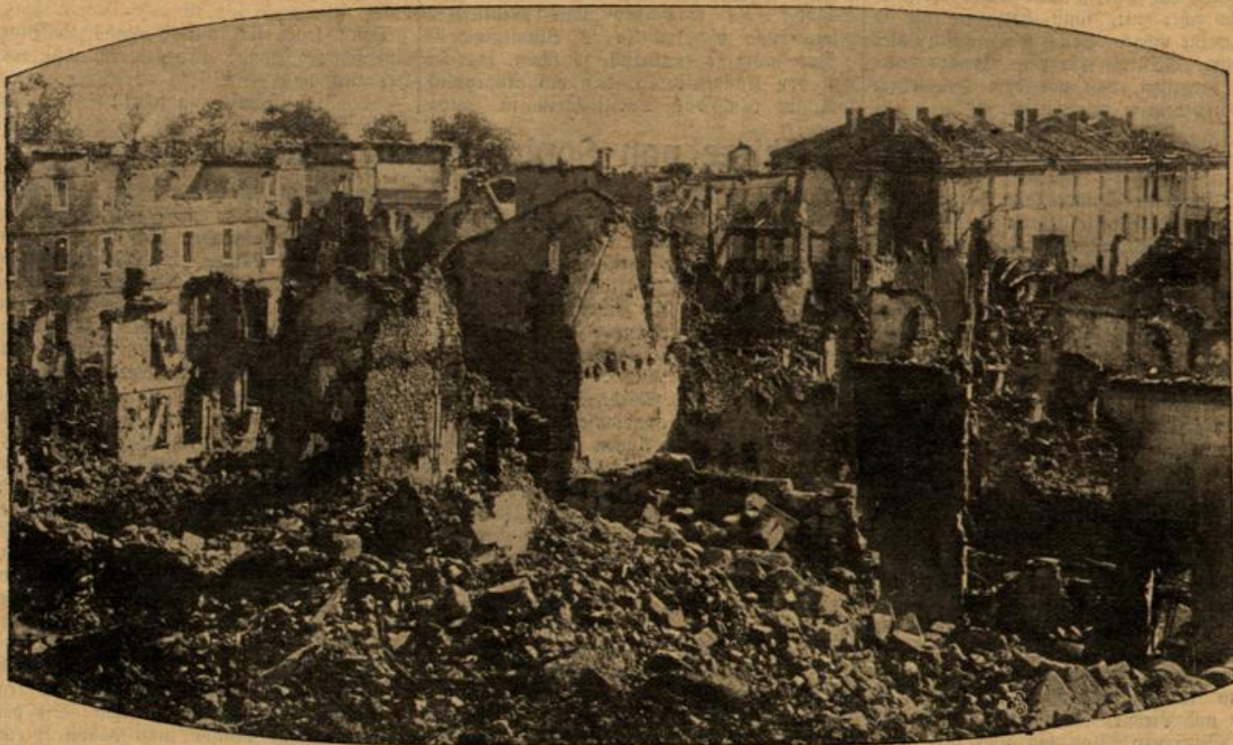
Nach der Beschießung: Blick auf das zerstörte Longwy Haut.
