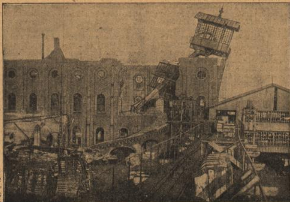
Eine vollständig zerstörte Kohlengrube bei Lens.
