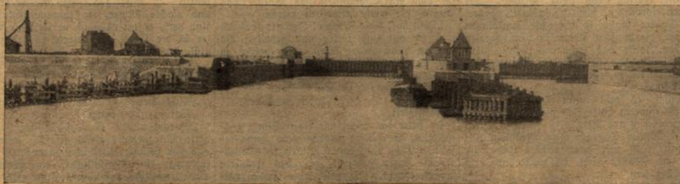
Von den Erweiterungsbauten im Kaiser-Wilhelm-Kanal: Die neuen Schleusenanlagen, die Mitte Juni dem Verkehr übergeben werden.
