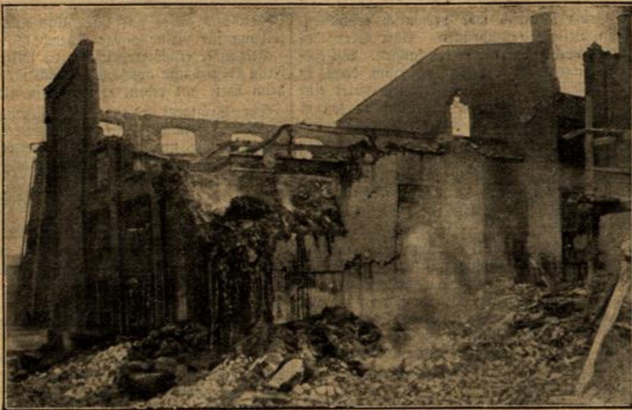
Zum Brand in Rosental bei Breslau, der größten Zuckerfabrik Schlesiens.
