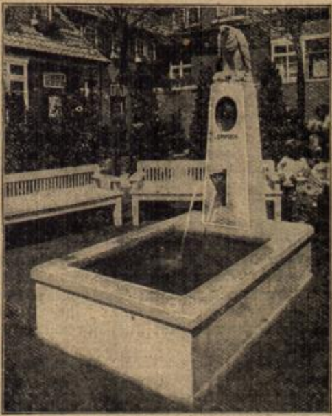
Der neue Emmichbrunnen in Hamburg.
