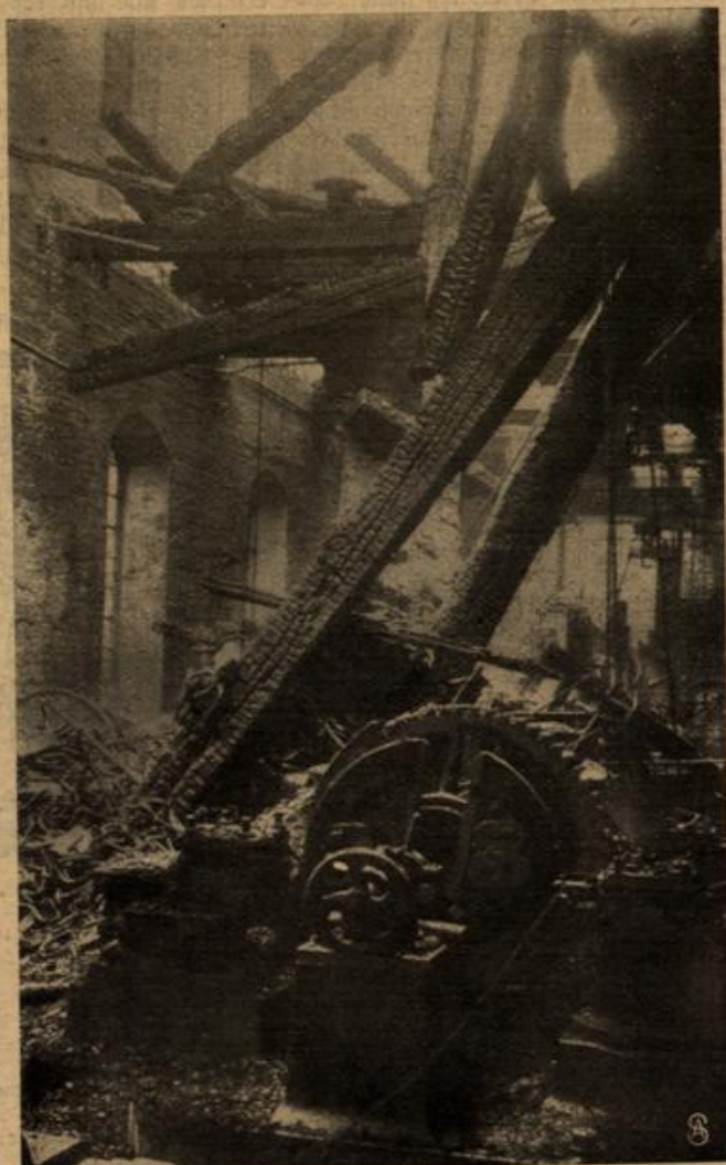
Das zerstörte Werkstättengebäude. Großfeuer auf dem Lehrter Güterbahnhof in Berlin.
