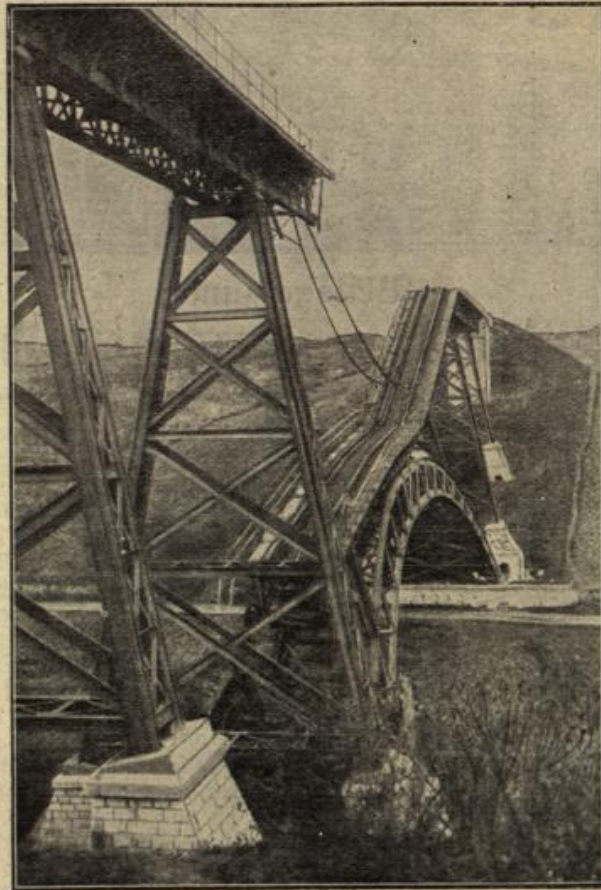
Zersprengte Eisenbahnbrücke bei Thiancourt-Toul. (Mit Text.)
