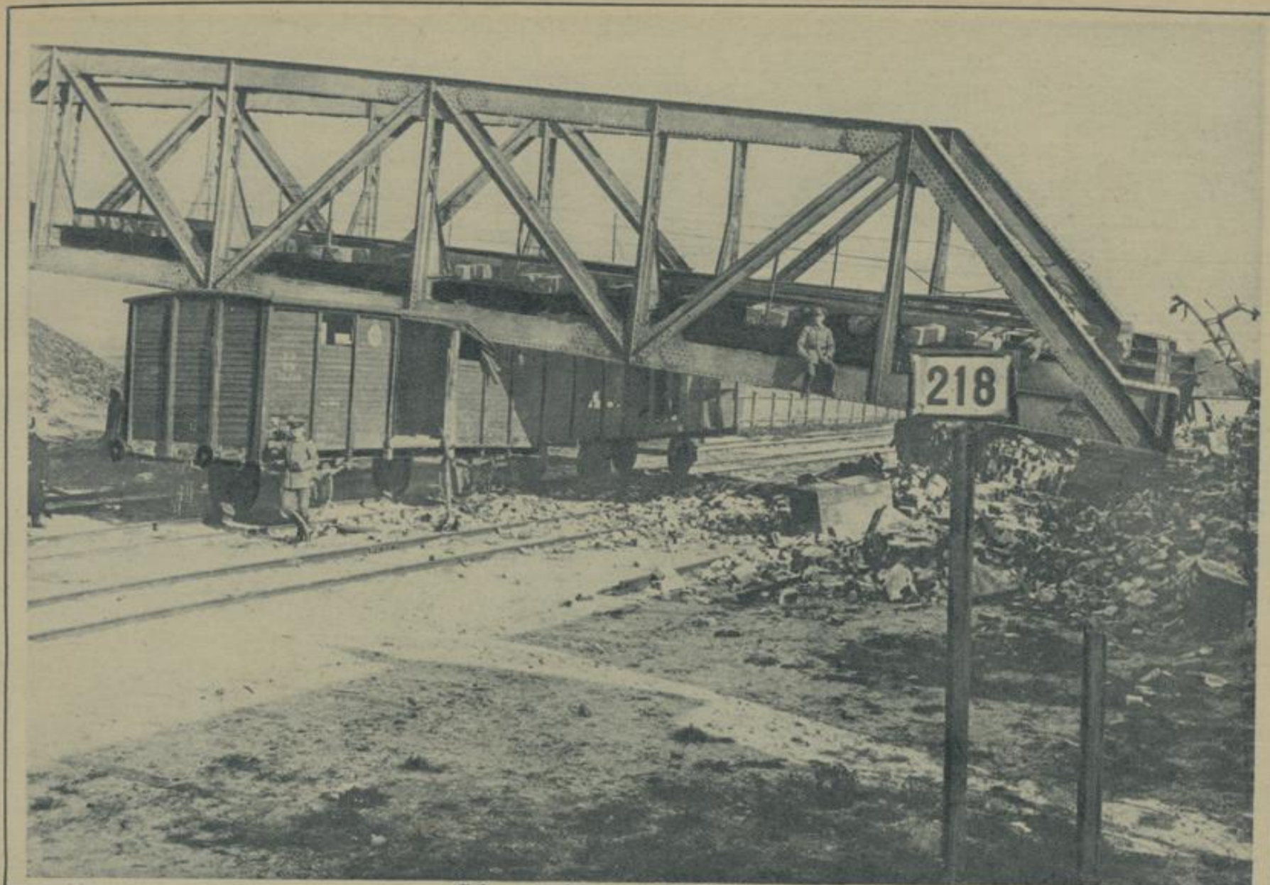
Gesprenge Eisenbahnbrücke bei Ezenstochau.
